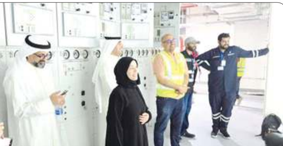
إيصال التيار الكهربائي لمبنى الركاب ب في المطار الجديد
