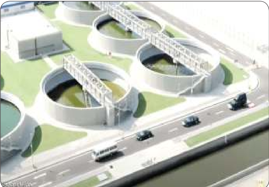
مشروع محطة معالجة المياه في مصر والتي أسهم الصندوق الكويتي بتمويلها
