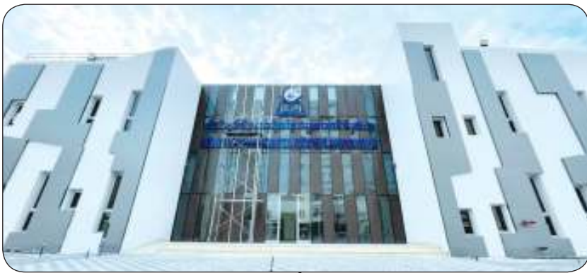
جانب من أعمال المبنى
