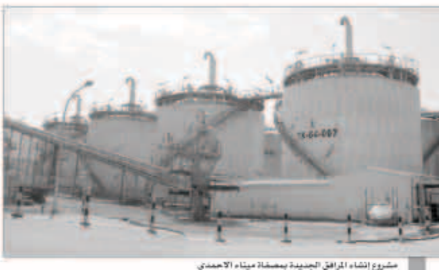
مشروع إنشاء المرافق الجديدة بمصفاة ميناء الاحمدي
