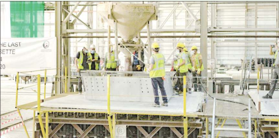
ممثلو وزارة الأشغال وفريق «ليماك» أثناء وضع آخر قطعة في سقف المطار
