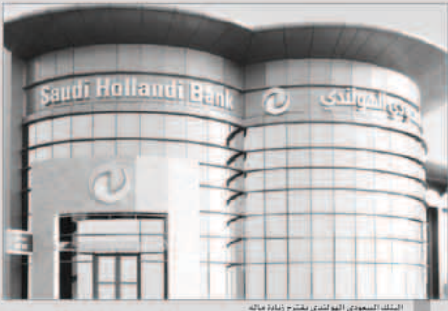
البنك السعودي الهولندي يقترح زيادة رأسماله
