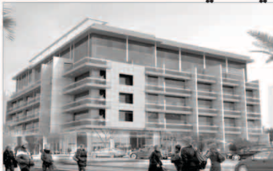
مشروع بناية فلامنجو
