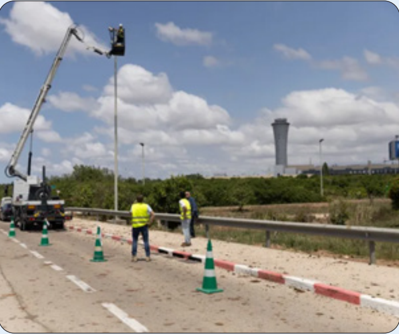
عمال إسرائيليون يصلحون كابل كهرباء تضرر بصاروخ باليستي أطلقه الحوثيون
