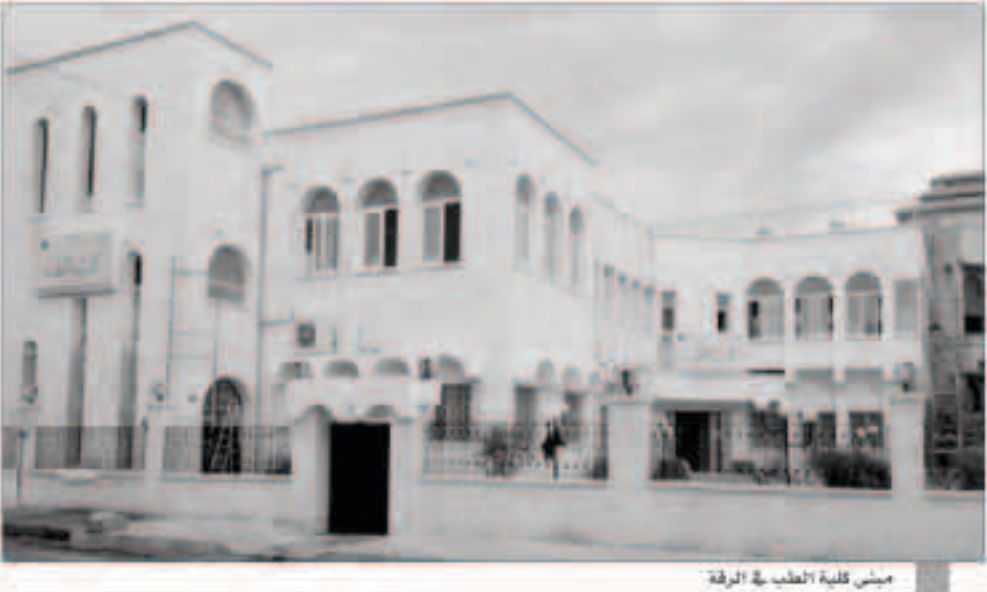
مبنى كلية الطب بة الرقة
