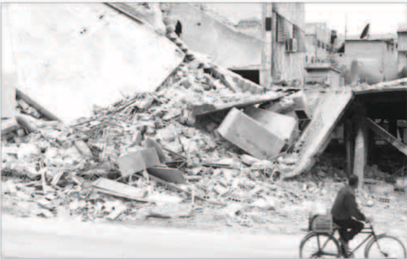
مبنى سمر في بلدة داريا السورية
