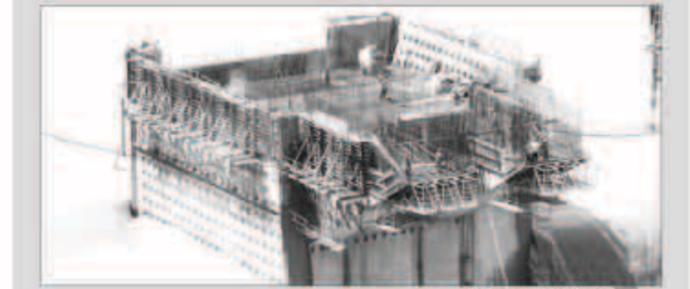
أعمال البناء في سد النهضة
