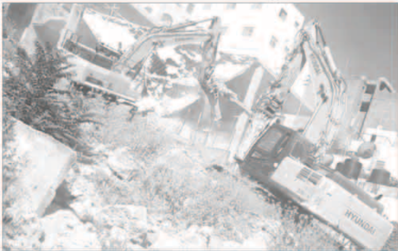
جرافات إسرائيلية تهدم منزلاً بمخيم شعفاط
