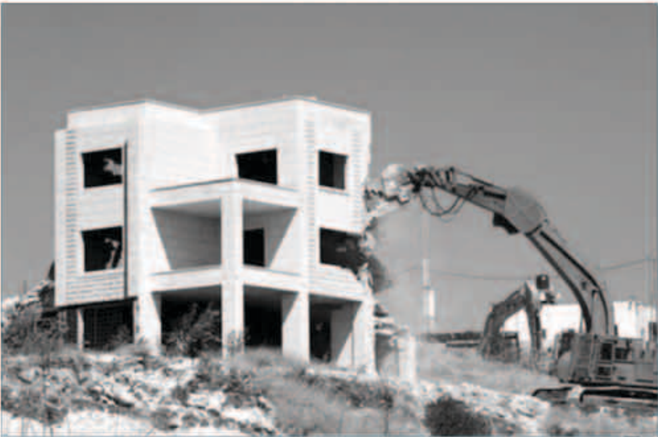
جرافات الاحتلال الإسرائيلي تهدم مبنى فلسطينيا جنوب القدس
