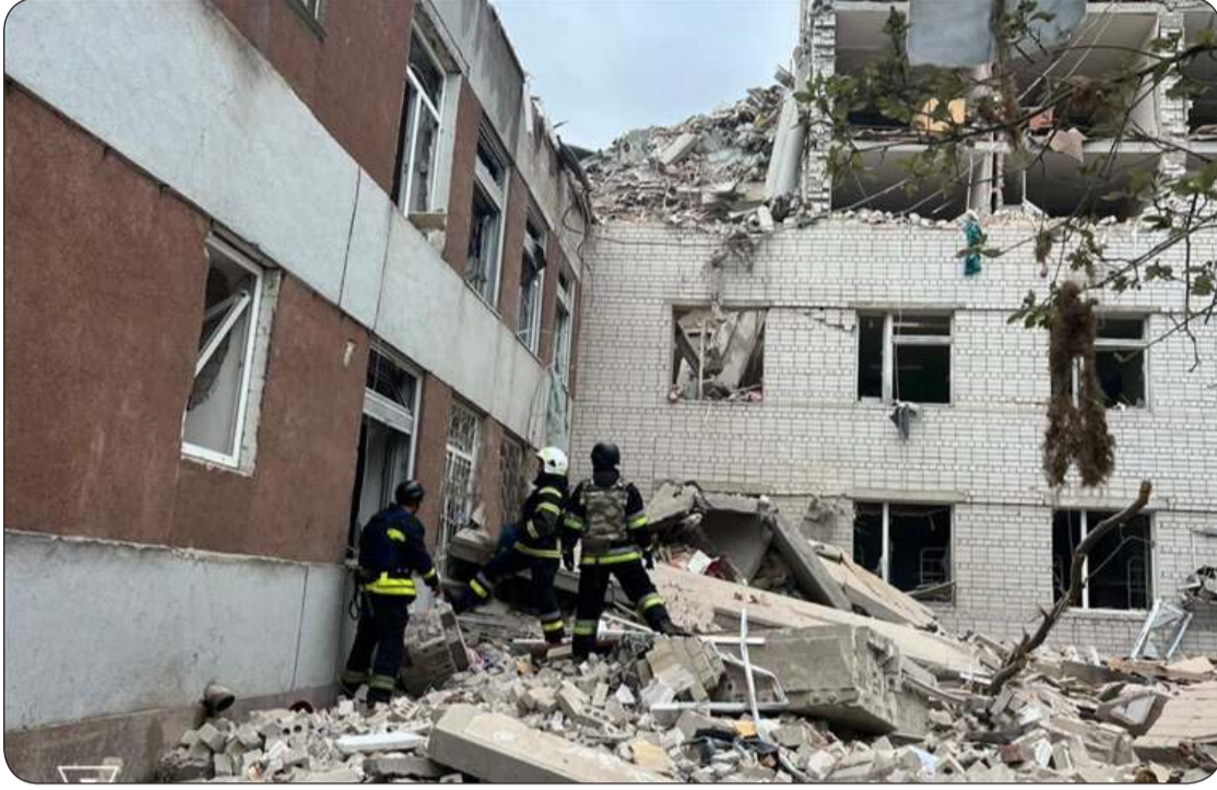
فريق إنقاذ يعمل في مبنى تشيرنيهيف تعرض لقصف روسي
