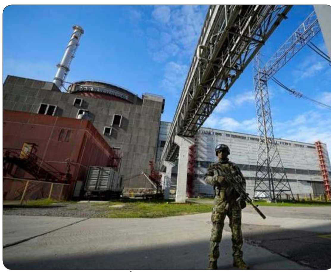
محطة زابورجيا النووية جنوب أوكرانيا
