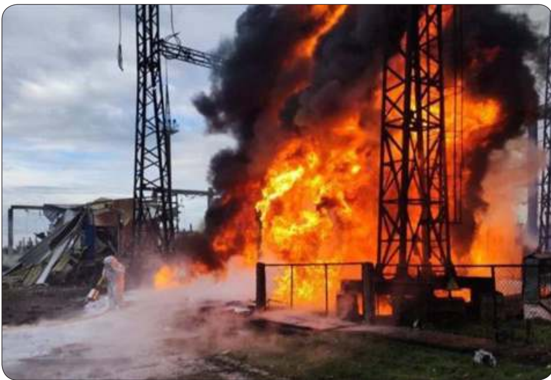
حريق في منشأة أوكرانية لنقل الكهرباء
