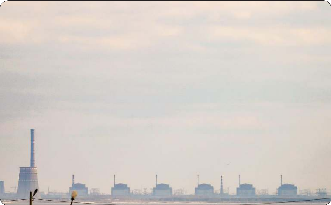
محطة زاباروجيا النووية تواجه انقطاعا في التيار الكهربائي
