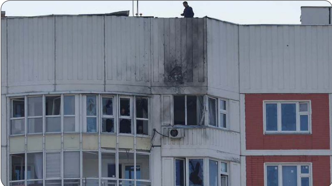
■ أضرار لحقت بأحد المباني في موسكو جراء هجمات الدرون
