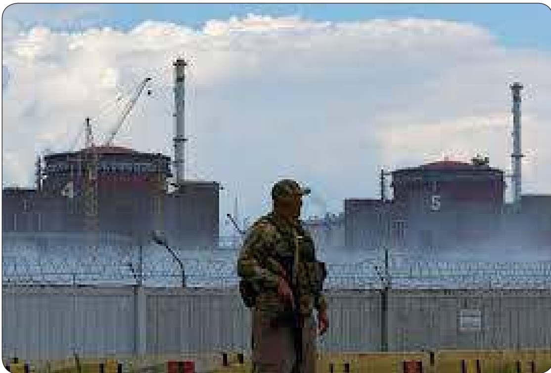
محطة زابوريجيا النووية جنوب أوكرانيا
