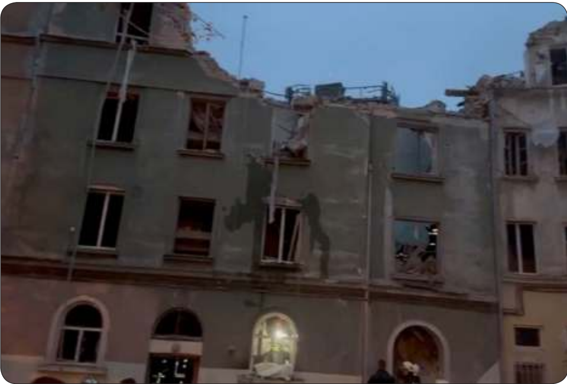
المبنى السكني المدمر في ليفيف
