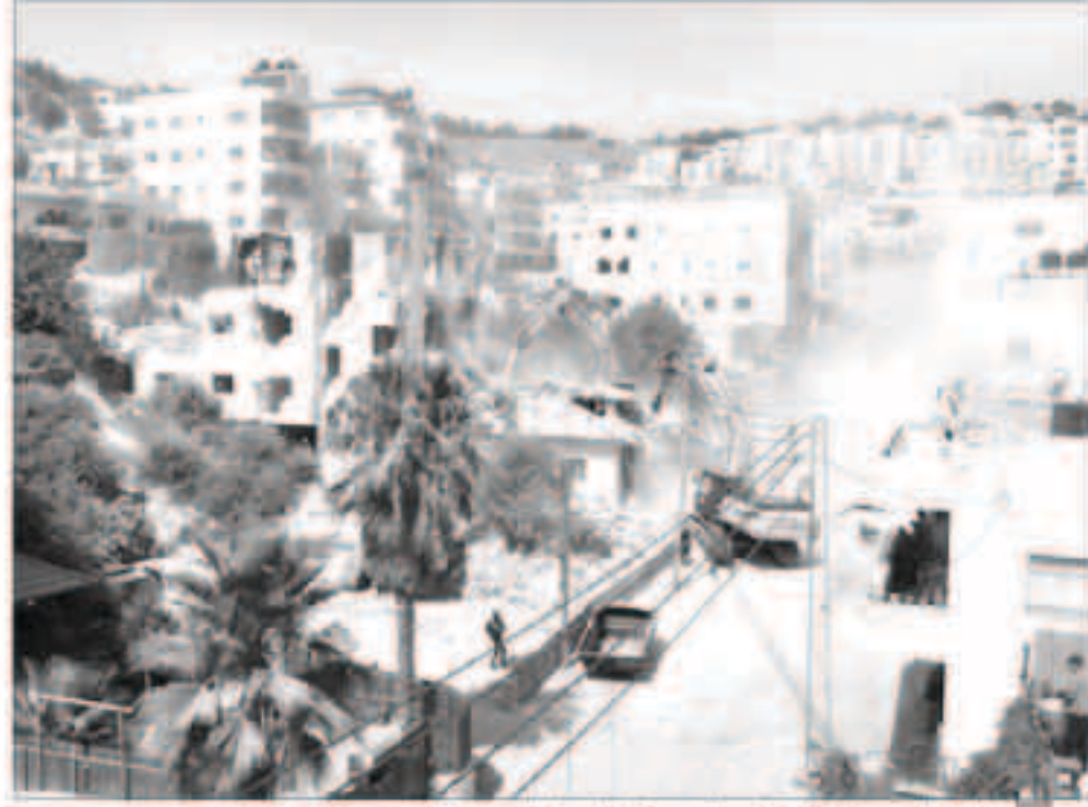
الاختلال يهدم بناية سكنية في حي العيسوية شمال مدينة القدس المحتلة بدعوى البناء دون ترخيص
