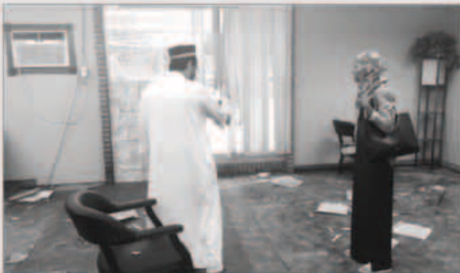
الأضرار التي لحقت ببيت من داخل المسجد
