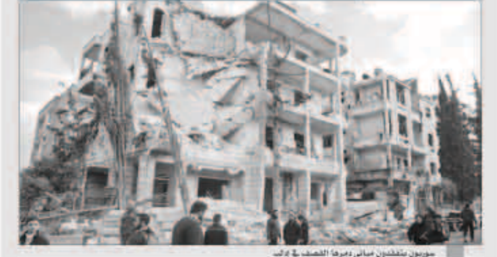
سوريون يتفحصون أضرارها القصف في إدلب
