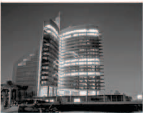
مبنى نفط الكويت
