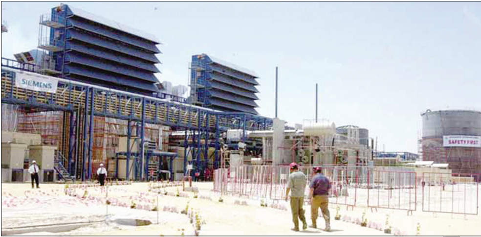
محطة الزور الجنوبية
