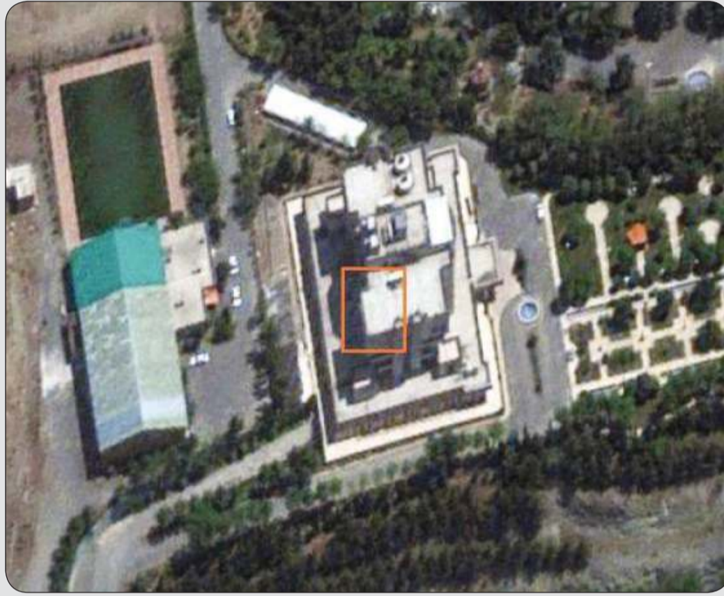
المبنى الذي كان يقيم فيه إسماعيل هنية بطهران لحظة استشهاده
