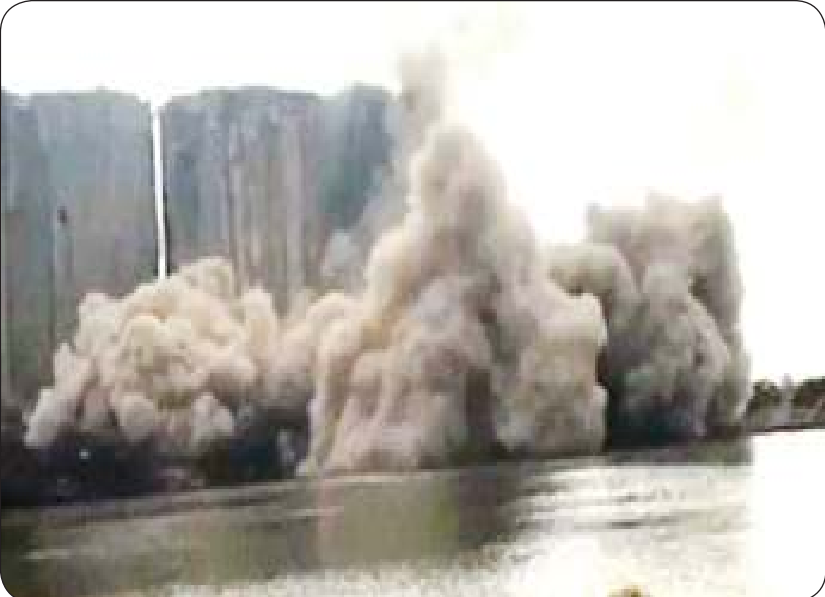
انهيار جزء من الصوامع في مرفأ بيروت
