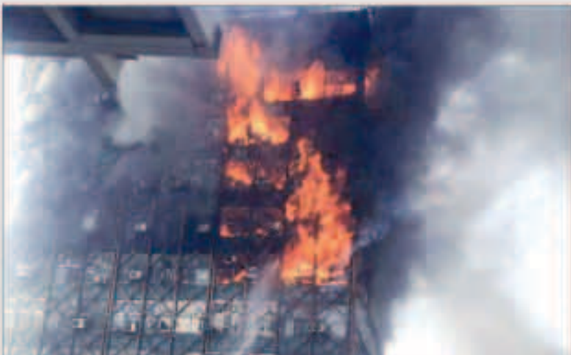
الحريق المروع أدى إلى انهيار برج تجاري بالكامل
