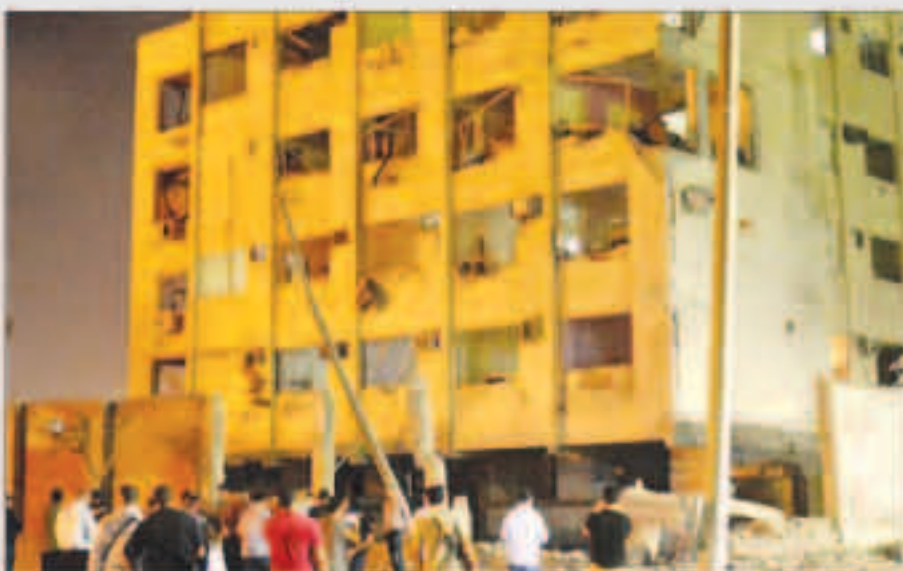
الانفجار حطم واجهة مبنى جهاز الأمن في شبرا الخيمة
