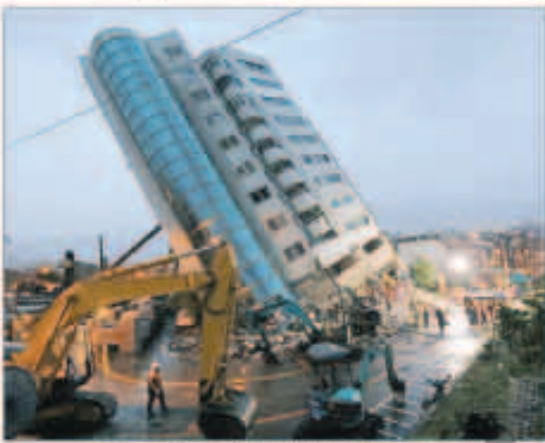
مبنى مدمر بعدما ضرب زلزال مدينة هوا لين في تايوان
