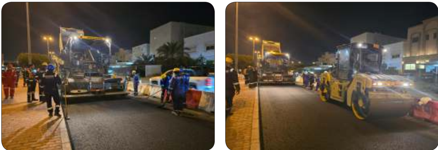
■ جانب من أعمال الصيانة
