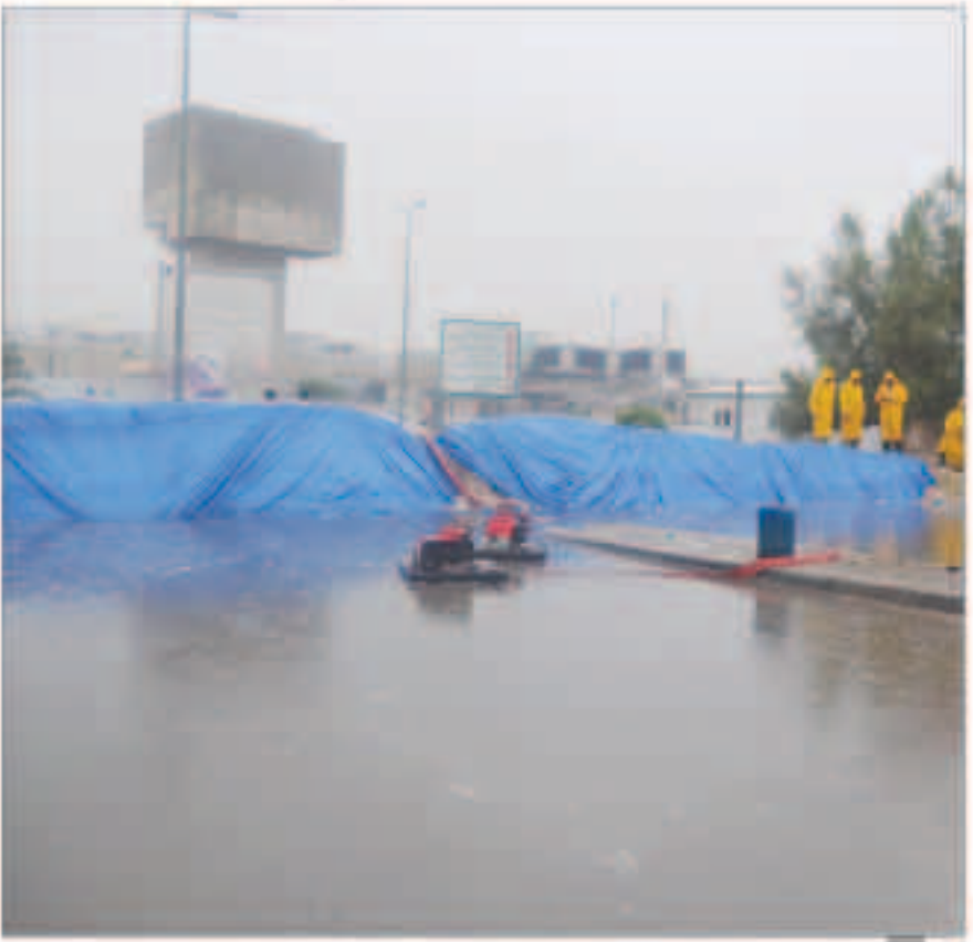
عمل المسدود لإجبار السيول على التراجع بعيد عن المناطق
