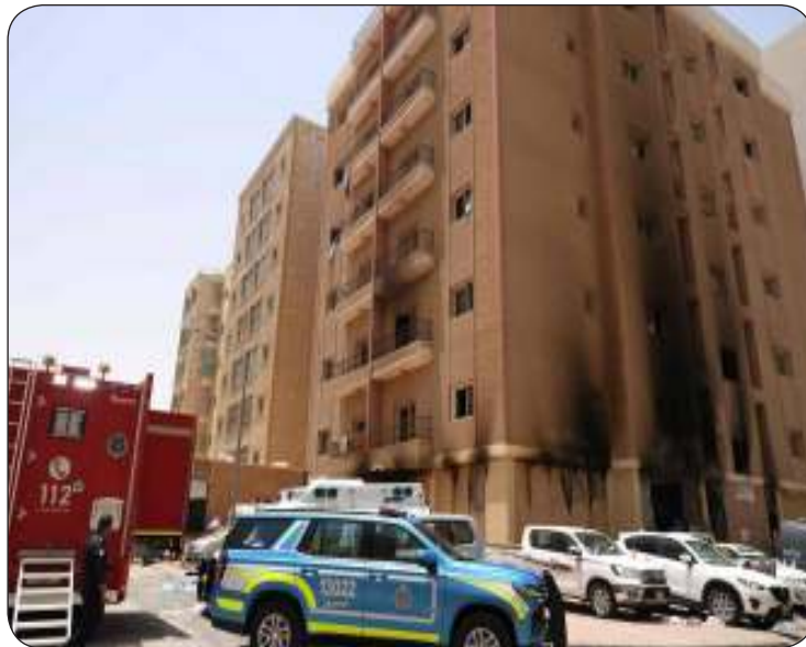
رجال الإطفاء بذلوا جهوداً مضنية لإخماد الحريق
