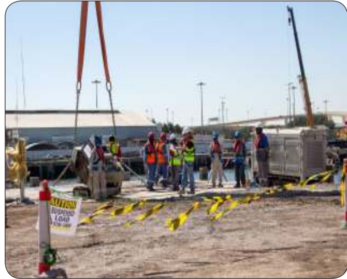
جانب من تدشين مشروع إعادة تطوير وتأهيل أرصفة ميناء الشويخ
