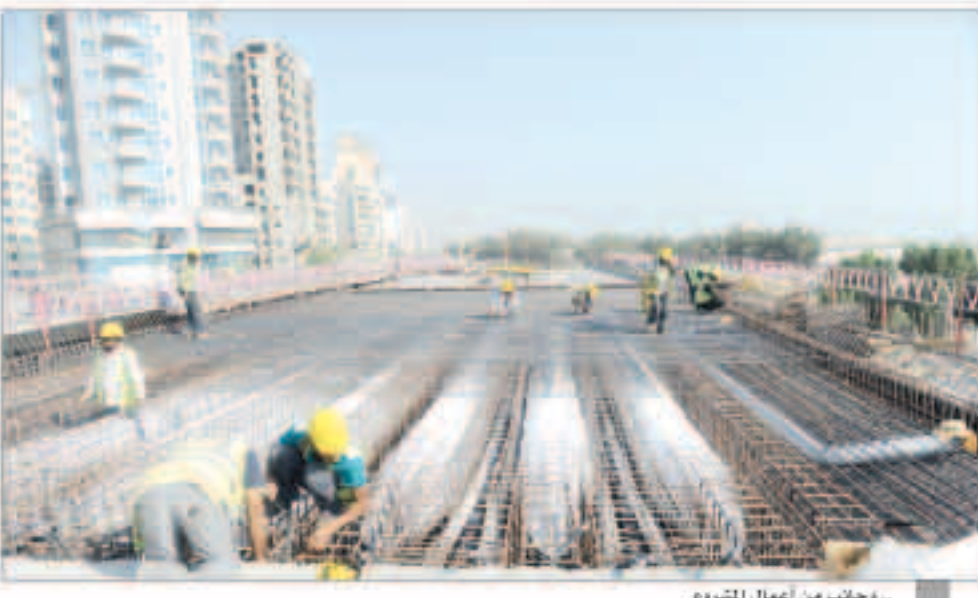
جانب من أعمال المشروع
