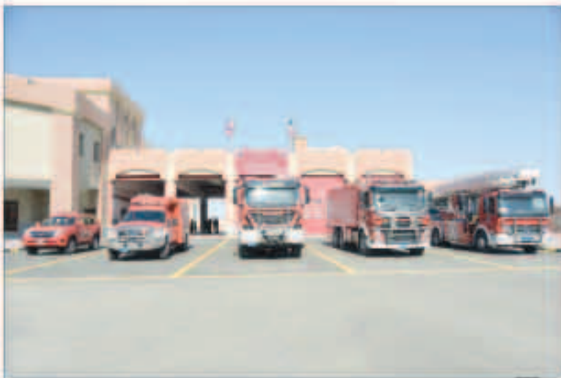
مبنى المركز الجديد في الجراح
