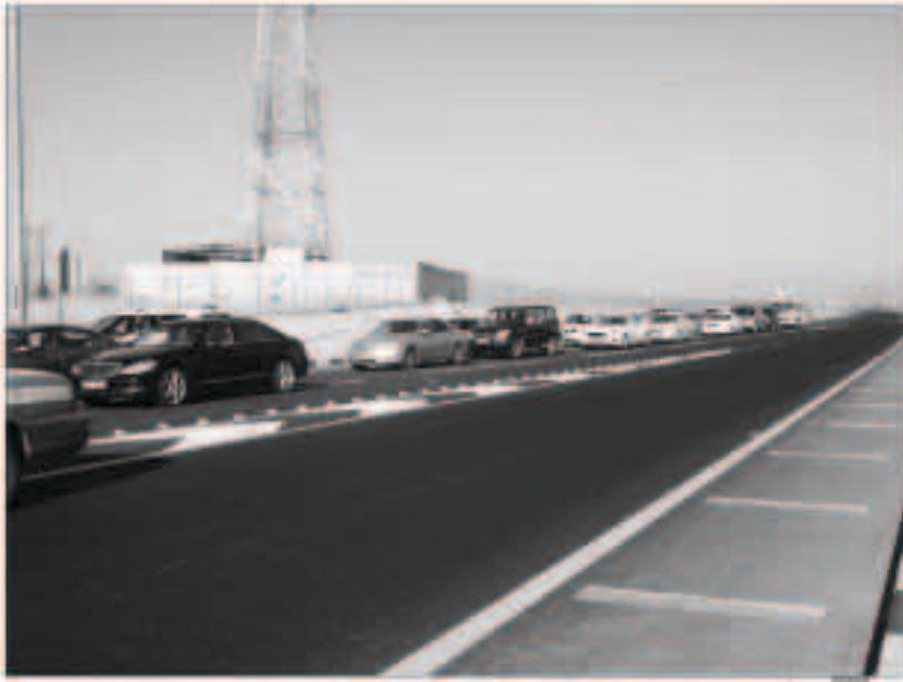
الأشغال تواصل استكمال مشاريع الطرق في مختلف أنحاء البلاد
