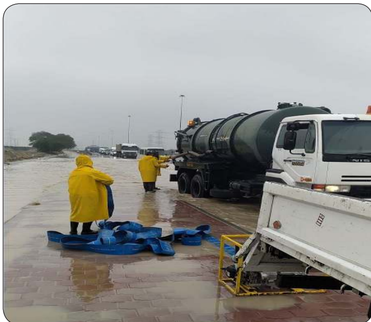
إحدى فرق الطوارئ التابعة للأشغال تعمل على فتح مسالك تصريف مياه الأمطار
