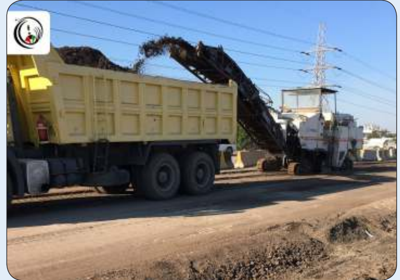
■ جانب من أعمال إصلاح الطرق
