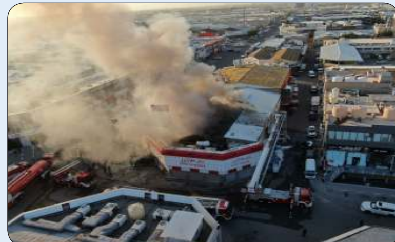
■ جانب من الحريق
