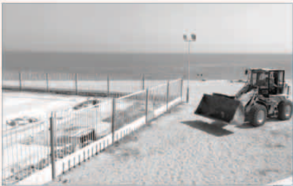
البلدية تزيل إحدى الواجيات
