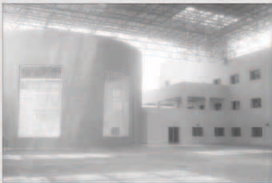
أحدى المدارس المستلمة
