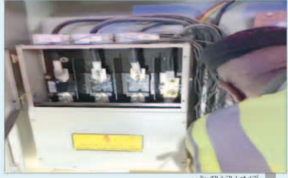
إثناء فصل التيار الكهربائي
