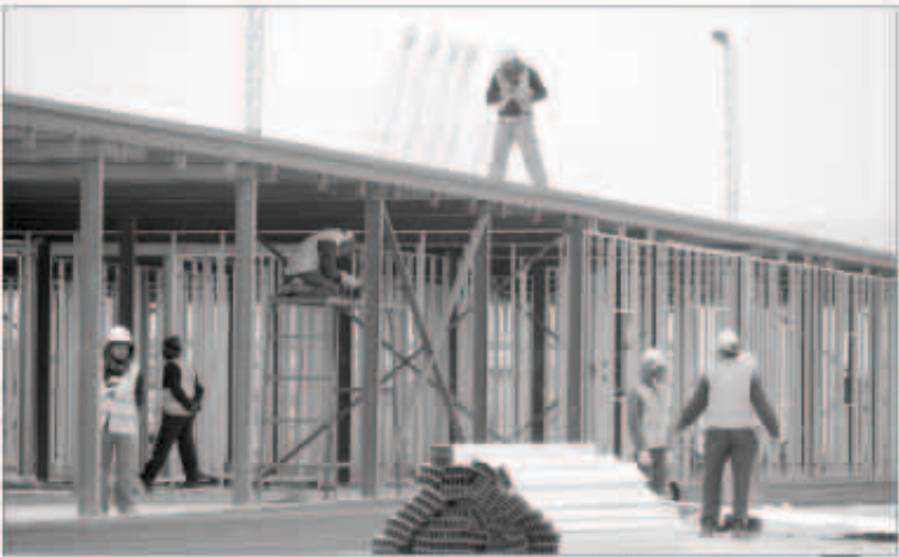
أعمال المشروع تسير وفق المخطط الزمني
