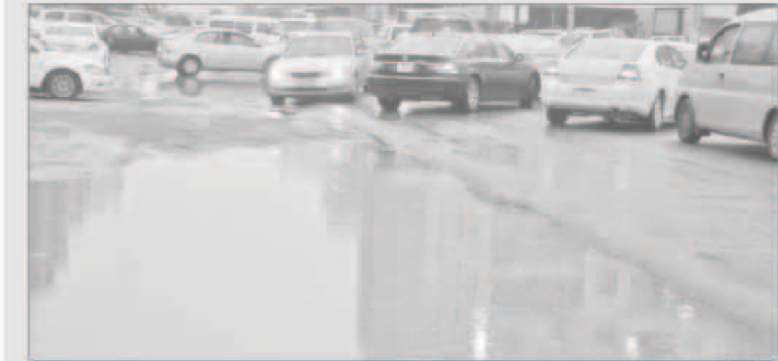
تجمع المياه على بعض الطرقات
