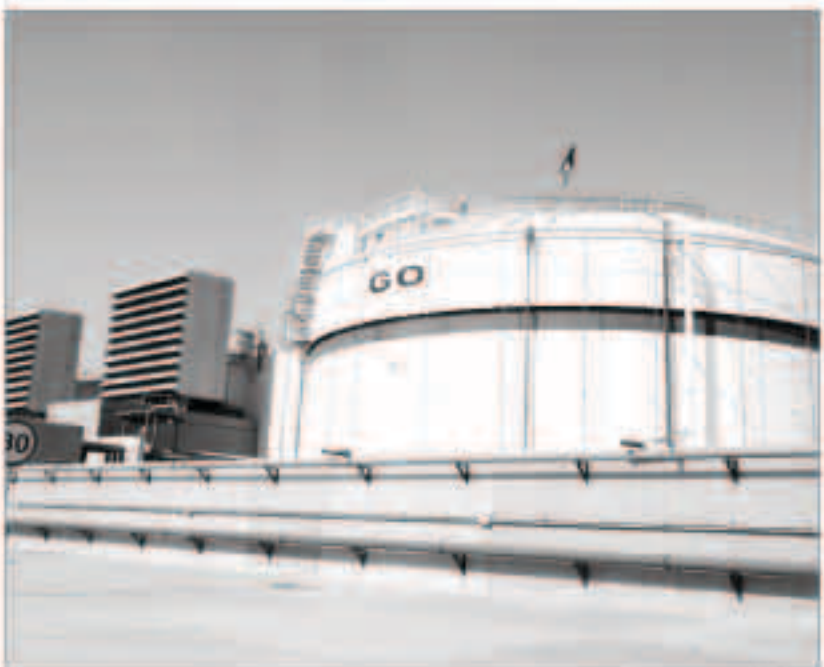
خزانات المحطة الجديدة
