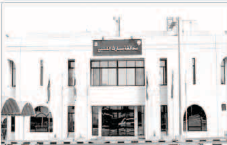
الاشغال تعلن إنجاز 9 في المئة من مشروع إنشاء مبنى محافظة مبارك الكبير
