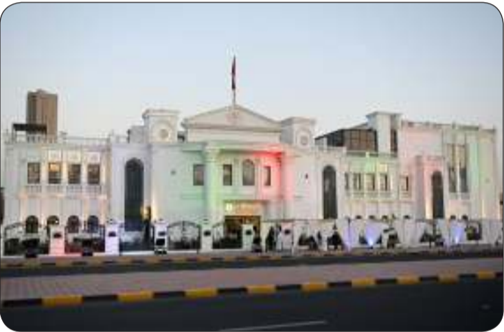
المبنى من الخارج
