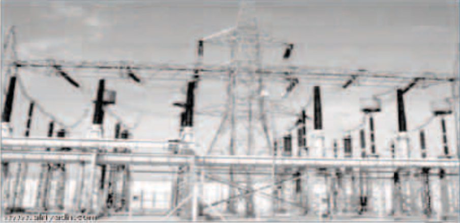
مشروع الربط الكهربائي الخليجي وأحد
