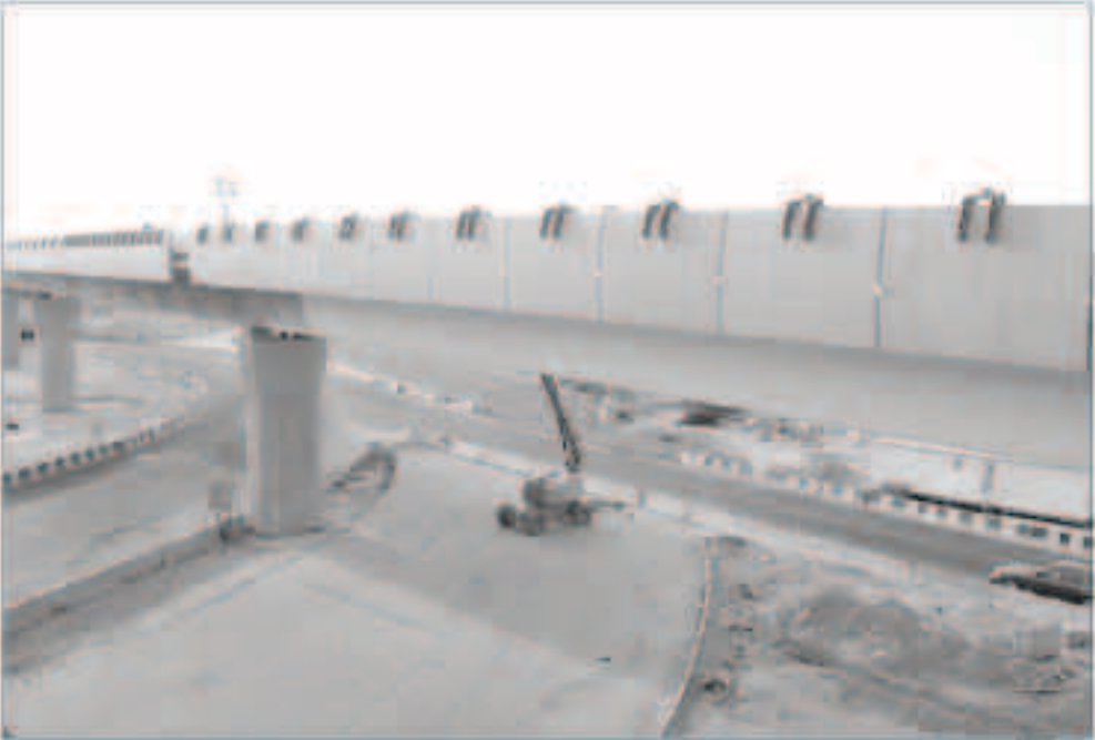
أعمال تركيب الجوائز الخرسانية
